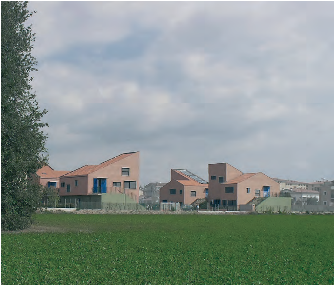
ostro + scirocco, edifici residenziali ibridi, 2006 - 2009 San Pietro in Casale, Bologna foto Davide Menis
